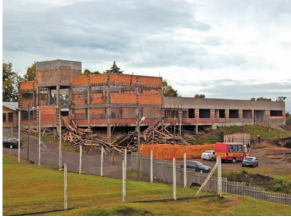
Obra do IFRS Caxias do Sul
